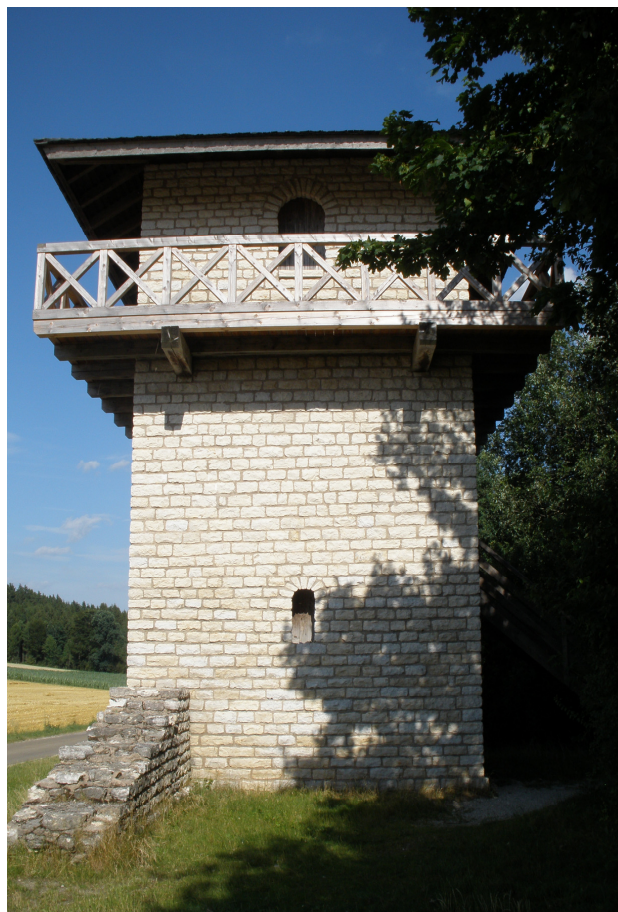
Abb. 6: Rekonstruierter Steinwachturm bei Erkertshofen
