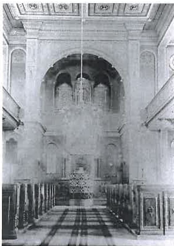
Obr.č. 7 Židovská synagoga v Táboře – interiér.
