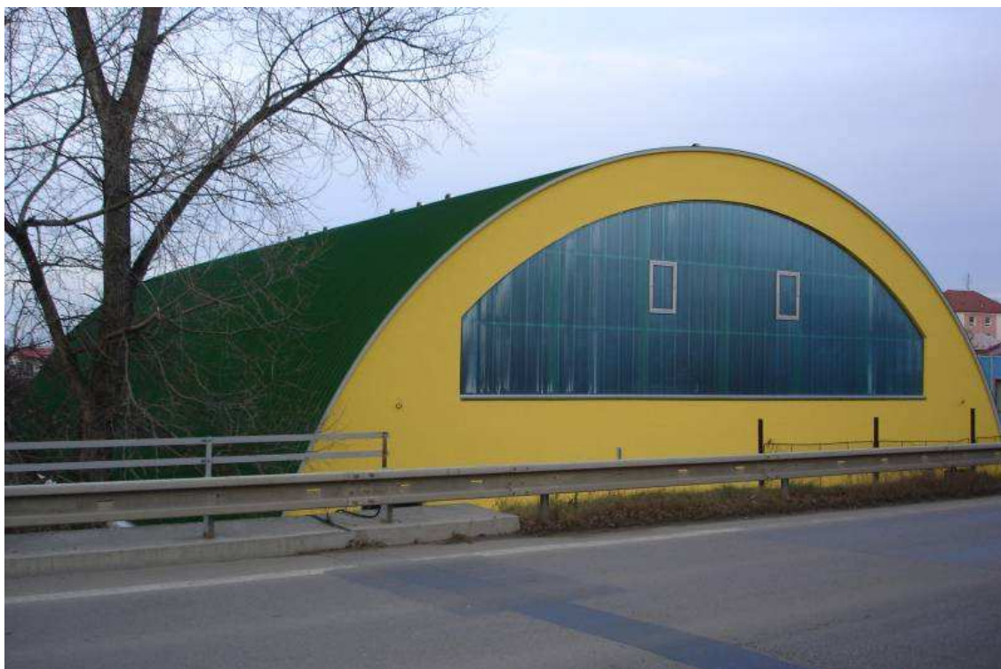
Příloha č. 4 Házénkářská hala Spartaku Sezimovo Ústí
