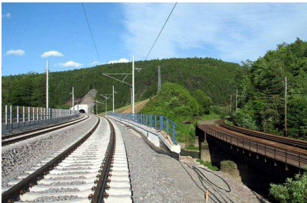
Obrázek 4: Pohled na železniční koridor na trati Olomouc-Česká Třebová, vpravo ještě původní trať.
