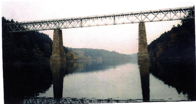
Železniční most v Červené nad Vltavou
