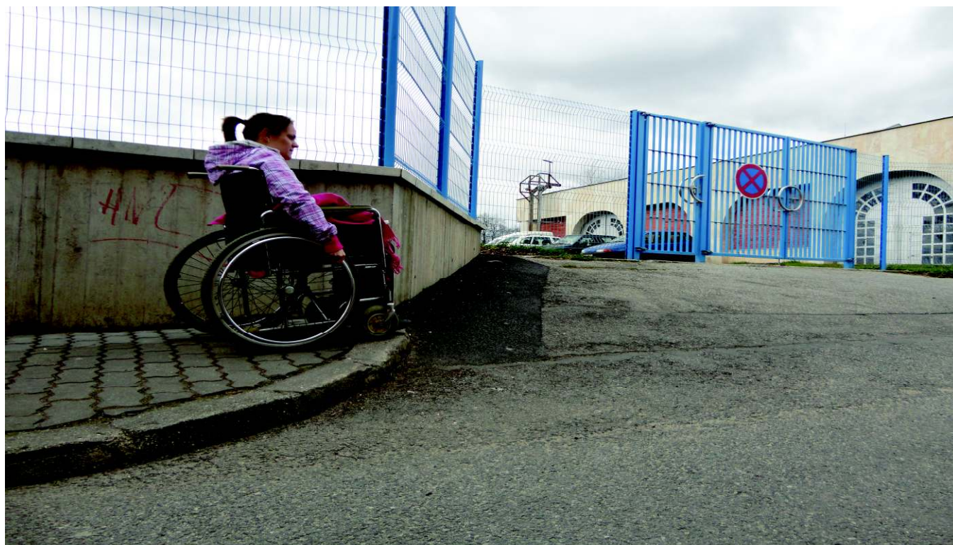
Obr. 20. Chybějící sjezd z chodníku, chodník končí šikmo do svahu (trasa II.)(foto-autorka)
