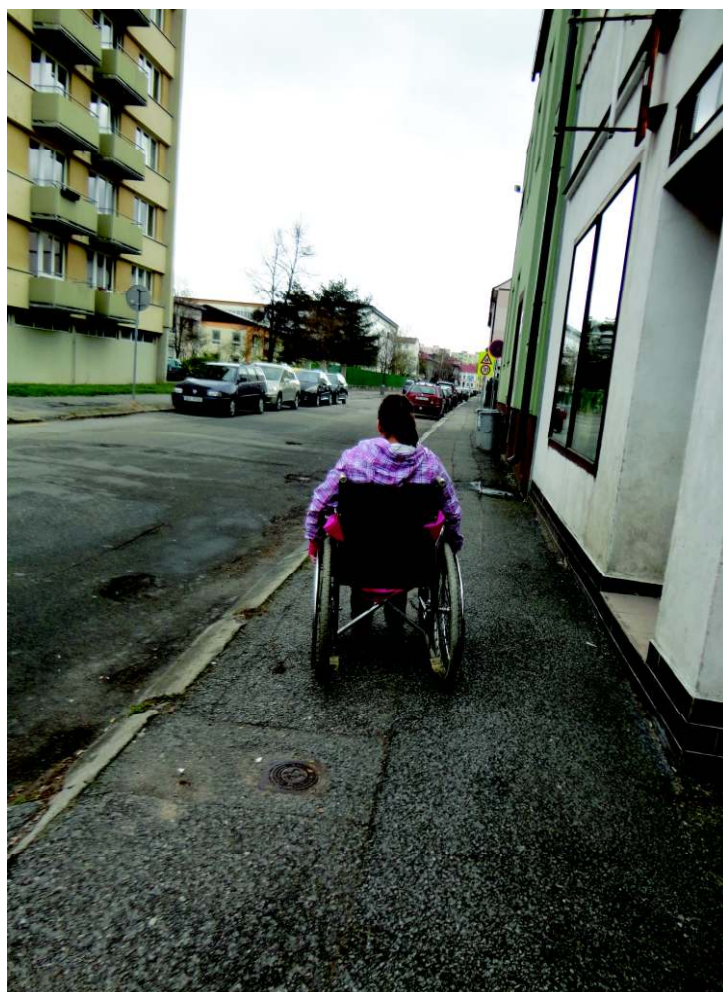
Foto. 8. Trasa k ISŠ stavební, propadlý chodník s terénními nerovnostmi (foto-autorka)
