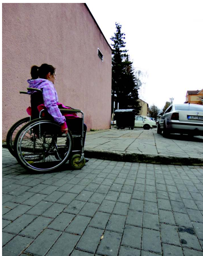
Obr. 17. Chybějící nájezd na chodník (ulice Kostelní) (foto-autorka)
