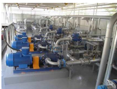
Obr. 10 a Obr. 11: Čerpadla na trasách ropovodů
