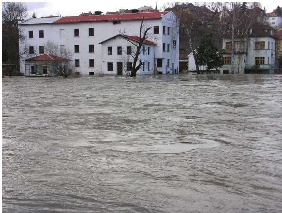
Povodeň duben 2002, Tábor, Veselých mlýn, Bechyňská ulice proti Lázním Čelkovice
