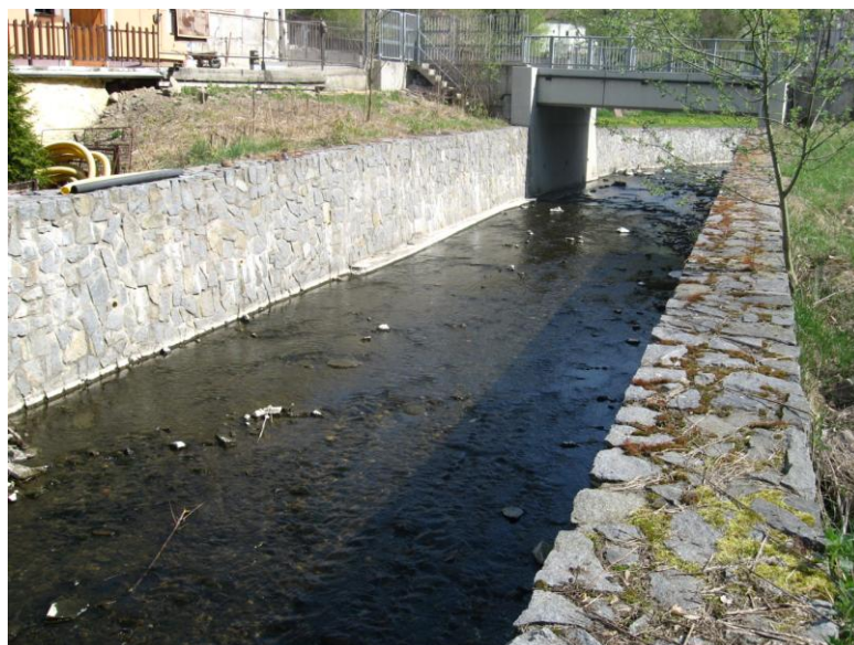
Pohled na část vyzděného koryta Tismenického (Košínského) potoka v lokalitě Pod ptákem
