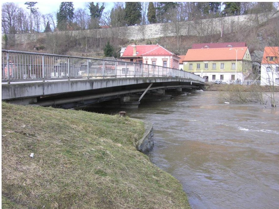
Povodně duben 2006, Tábor, most z Čelkovic do ulice Lužnická
