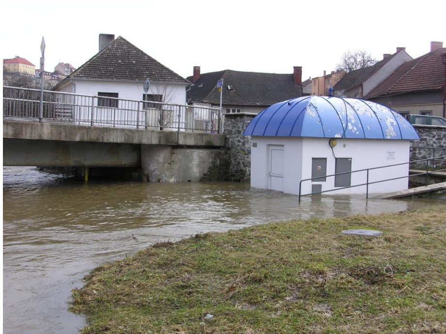
Povodeň duben 2002, Tábor-Čelkovice, zatopená trafostanice, na levém břehu řeky
