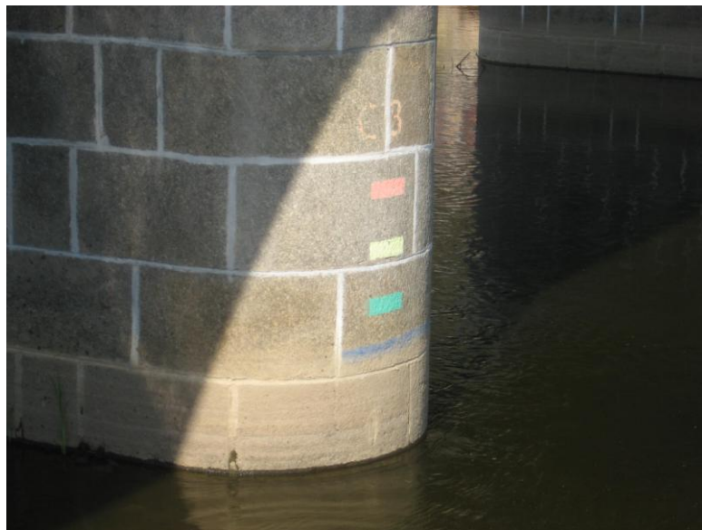
Detailní pohled na pilíř Čelkovického mostu s barevným označením výšky hladiny
