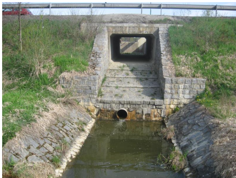
Pohled na rekonstruovaný bezpečnostní přepad pod silnicí vedoucí na Chýnov u Chotovinského potoka, s Knížecím rybníkem
