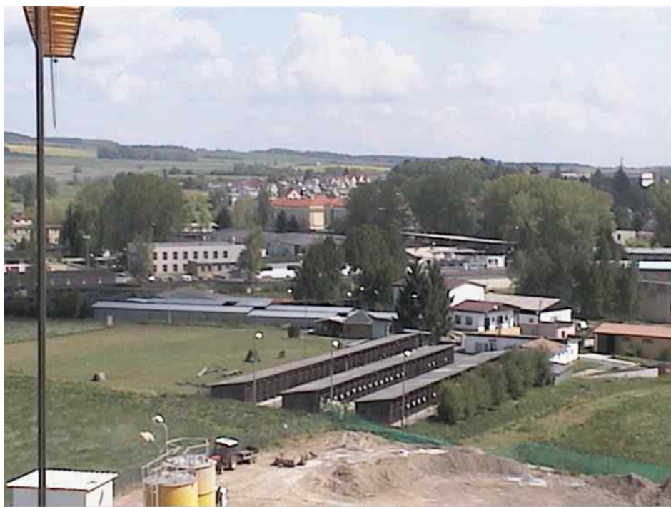
Chovná stanice Prackovice nad Labem.
