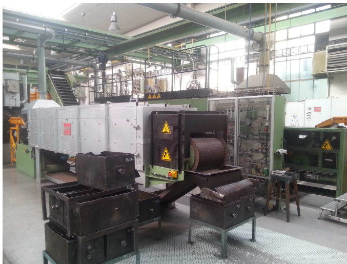
Obr. č. 25 Automatická pec Safed
