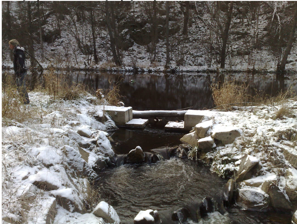
Foto 4: Rybí přechod SO 02 – výstup rybího přechodu
