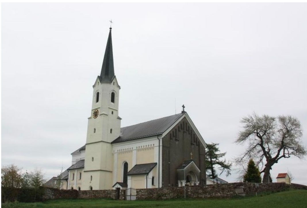
Obrázek 4.5 Světlícký kostel po dokončení rekonstrukci
