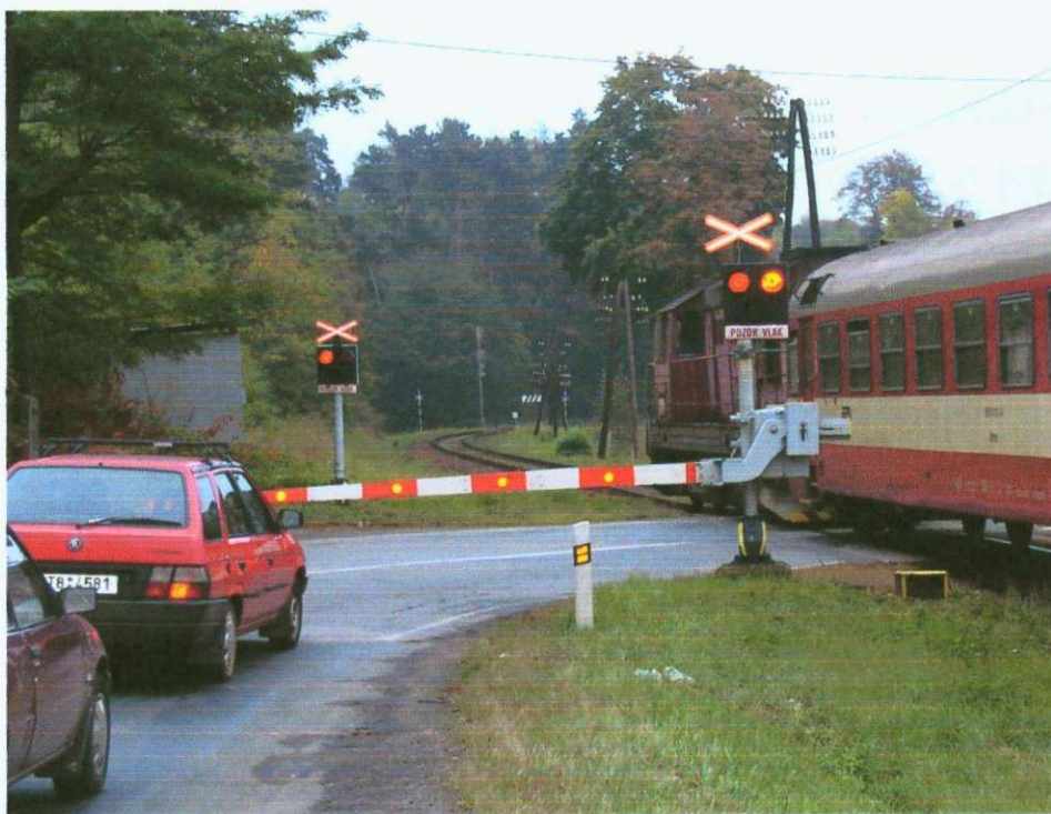
Obrázek 10. Přejezdové zabezpečovací zařízení AŽD 71 se závorami.
