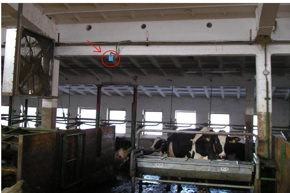
Obrázek 2: Pohybovou aktivitu dojnic snímá z transponderů přijímač umístěné u stropu stáje
