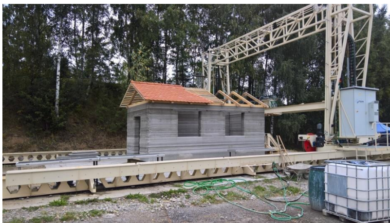
Obrázek 1.16: Dům postavený pomocí české 3D tiskárny, která je řešena jako portál (fs.cvut.cz, 2022b)
