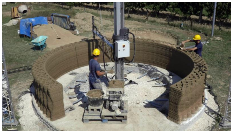
Obrázek 1.15: Stavebí 3D tiskárna řešená jako robotická paže (ceskestavby.cz, 2020)
