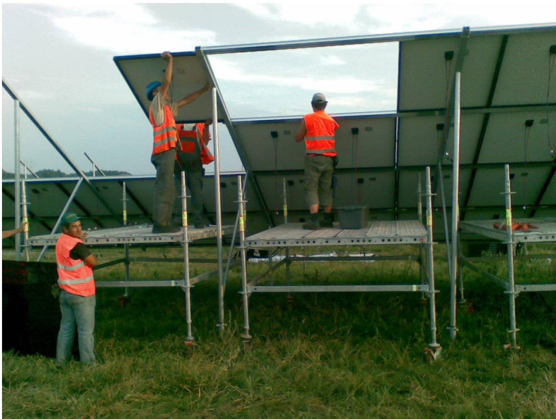
Obrázek 3: Výstavba fotovoltaické elektrárny v Čejči (Ing. Malivánek, 2009)
