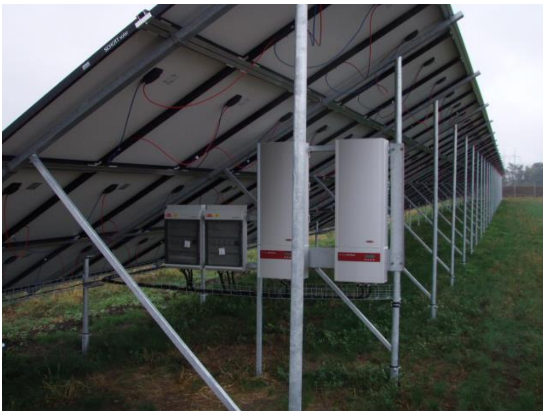
Obrázek 4: Výstavba fotovoltaické elektrárny v Čejči (Ing. Malivánek, 2009)
