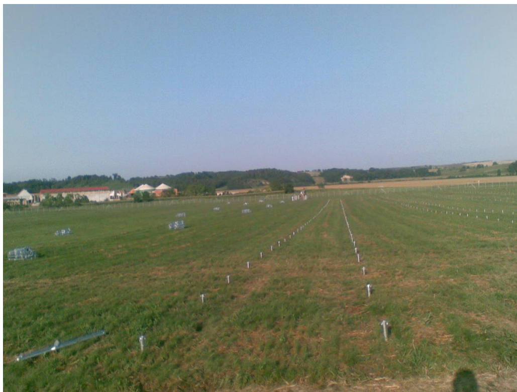
Obrázek 1: Výstavba fotovoltaické elektrárny v Čejči (Ing. Malivánek, 2009)
