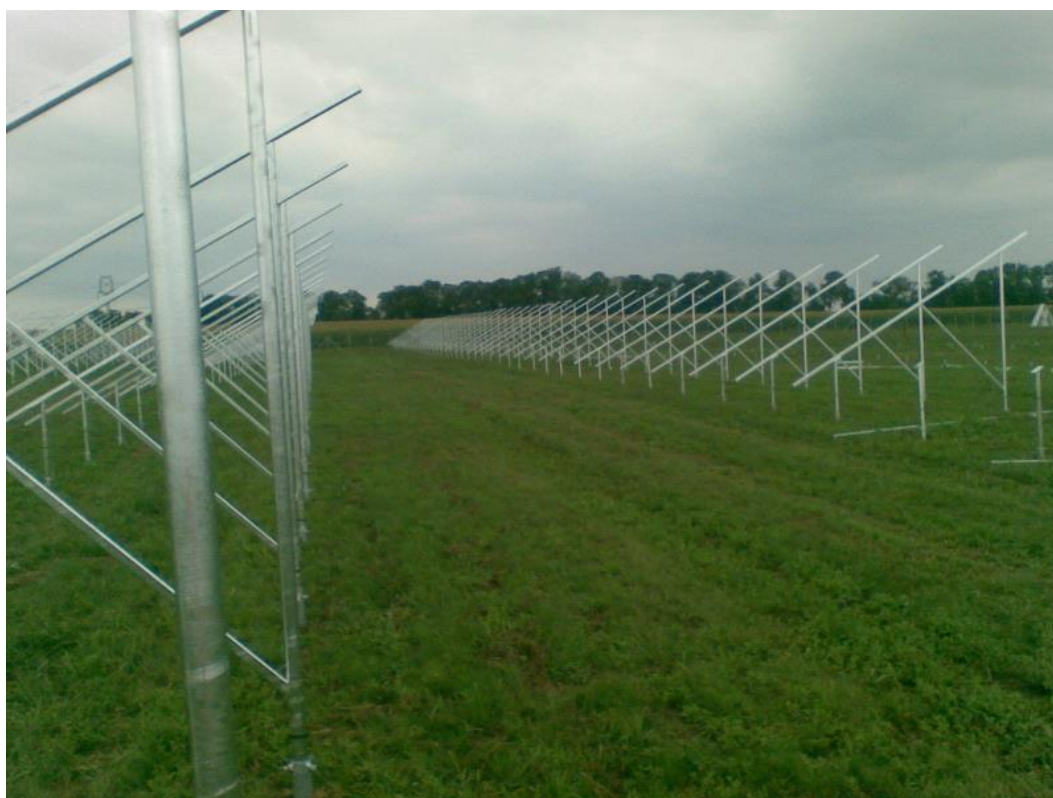
Obrázek 2: Výstavba fotovoltaické elektrárny v Čejči (Ing. Malivánek, 2009)
