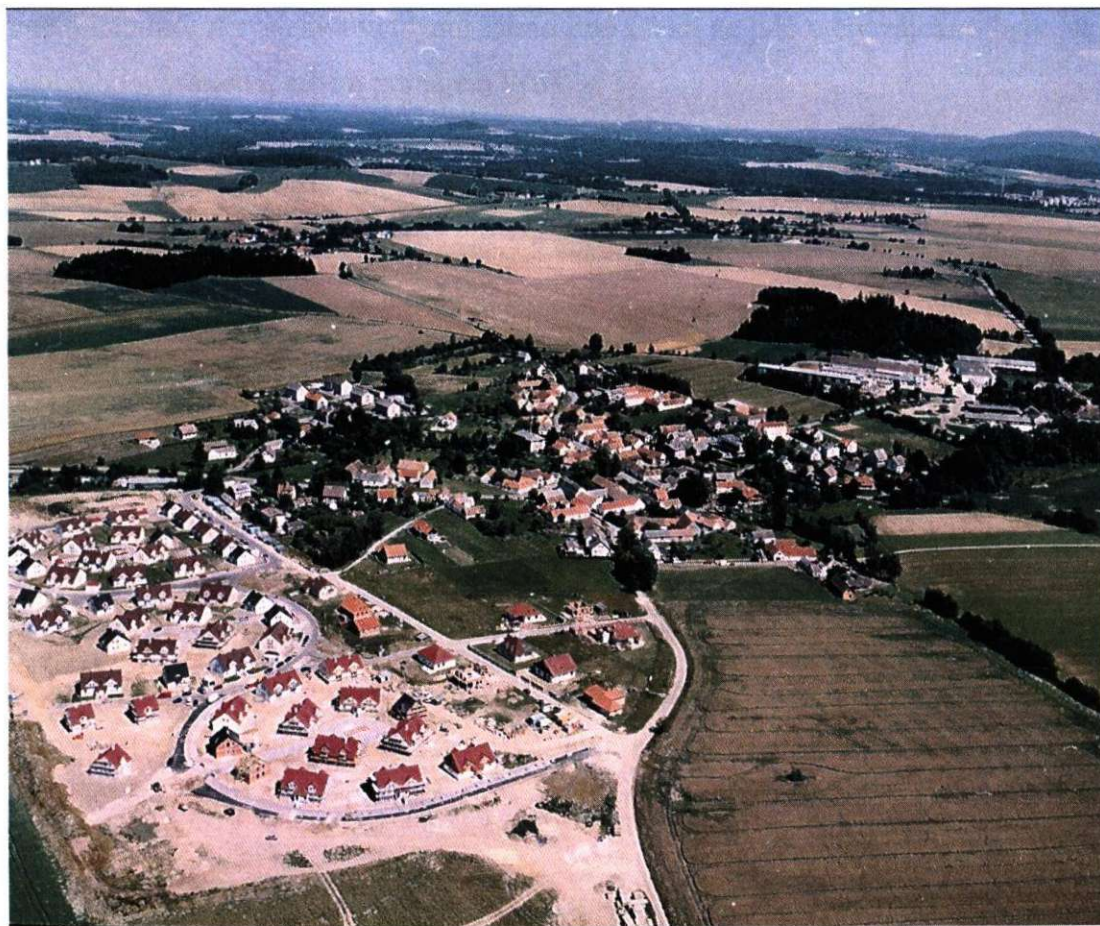
Obr. 2: Výstavba bytových domů
