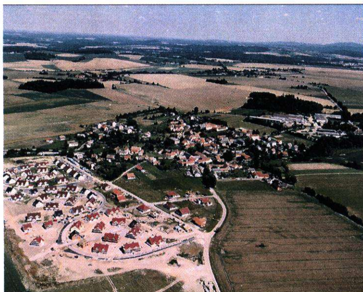
Obr. č. 1: Probíhající výstavba bytových domů
