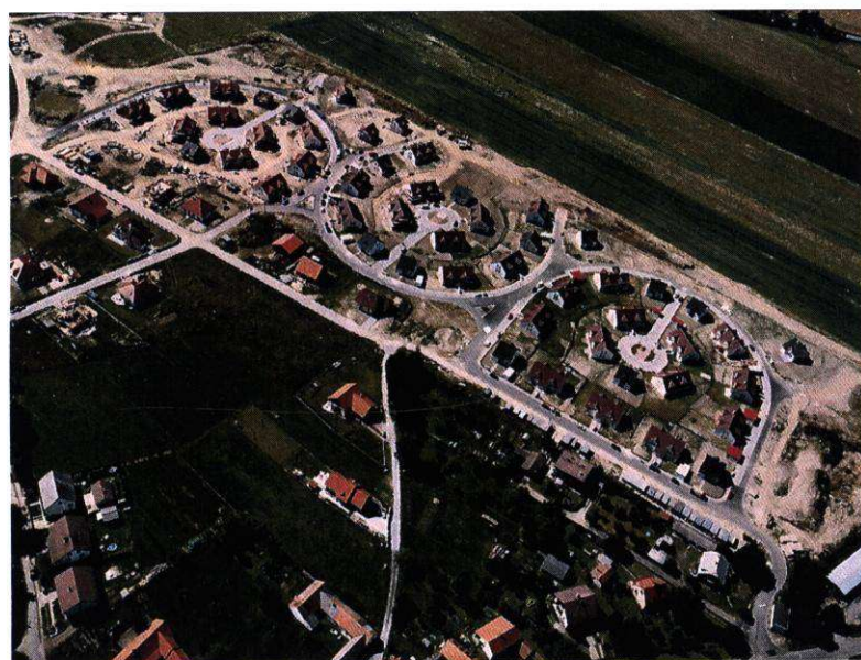
Obr. č. 2: Probíhající výstavba bytových domů
