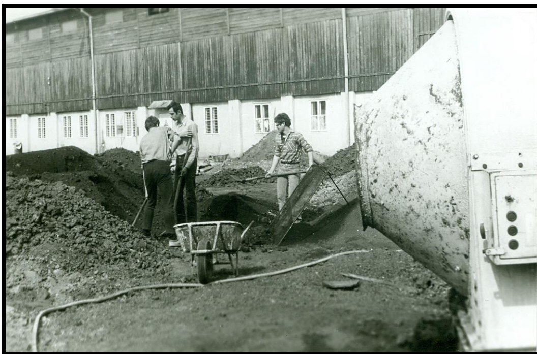
Příloha 42: Stavba antukových kurtů na tenis na stadionu na Dlouhé louce v roce 1976, zdroj: Archiv KTVS v Č. B.
