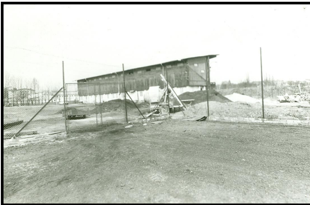
Příloha 40: Stavba antukových kurtů na tenis na stadionu na Dlouhé louce v roce 1976, zdroj: Archiv KTVS v Č. B.
