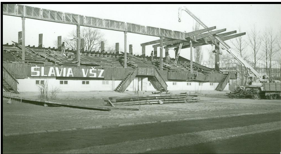
Příloha 49: Bourání tribuny na stadionu na Dlouhé louce, zdroj: Archiv KTVS v Č. B.
