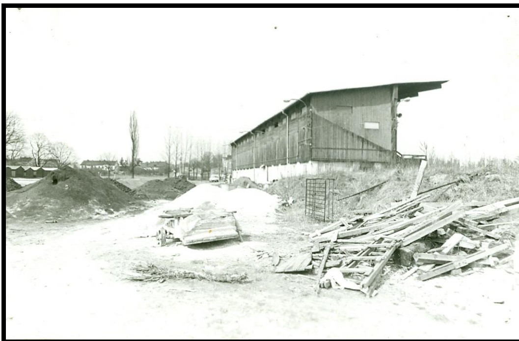
Příloha 41: Stavba antukových kurtů na tenis na stadionu na Dlouhé louce v roce 1976, zdroj: Archiv KTVS v Č. B.
