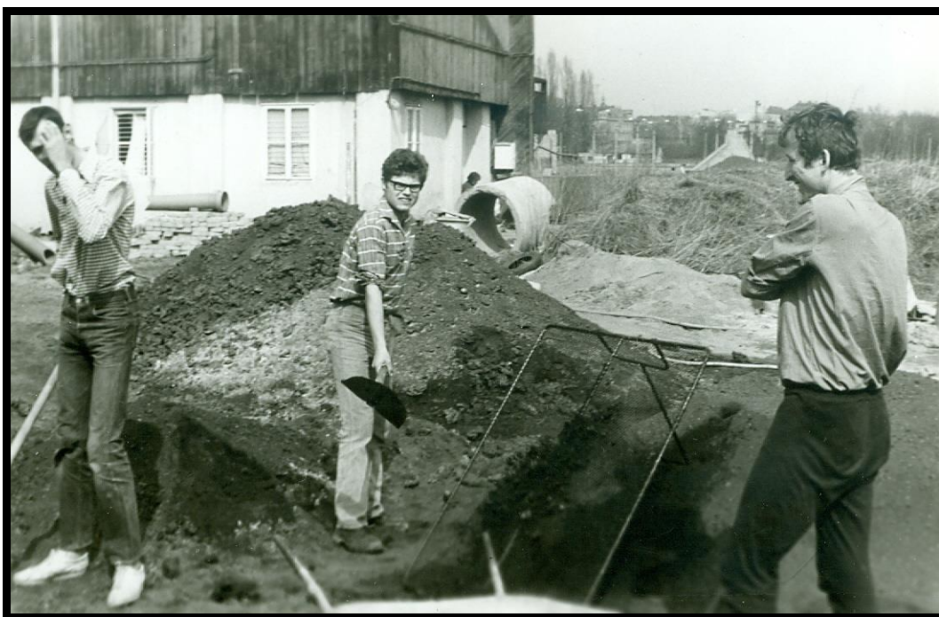
Příloha 39: Stavba antukových kurtů na tenis na stadionu na Dlouhé louce v roce 1976, zdroj: Archiv KTVS v Č. B.
