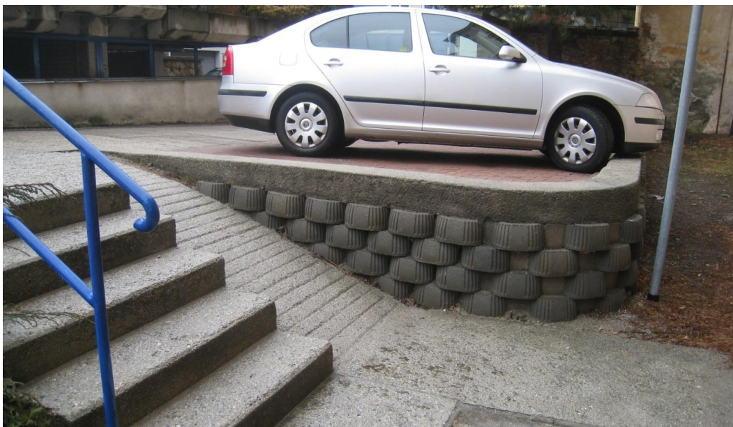
Příliš velký sklon nájezdové rampy
