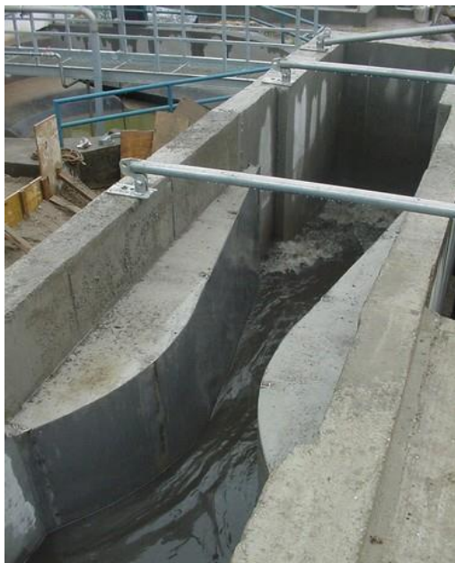
Obrázek 1.8: Venturiho žlab (papay.sk, 2022)
