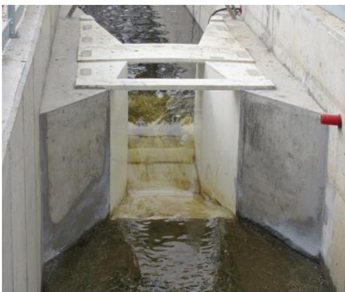
Obrázek 1.6: Pohled na Parshallův žlab (cdn.bitrix24.eu, 2022)
