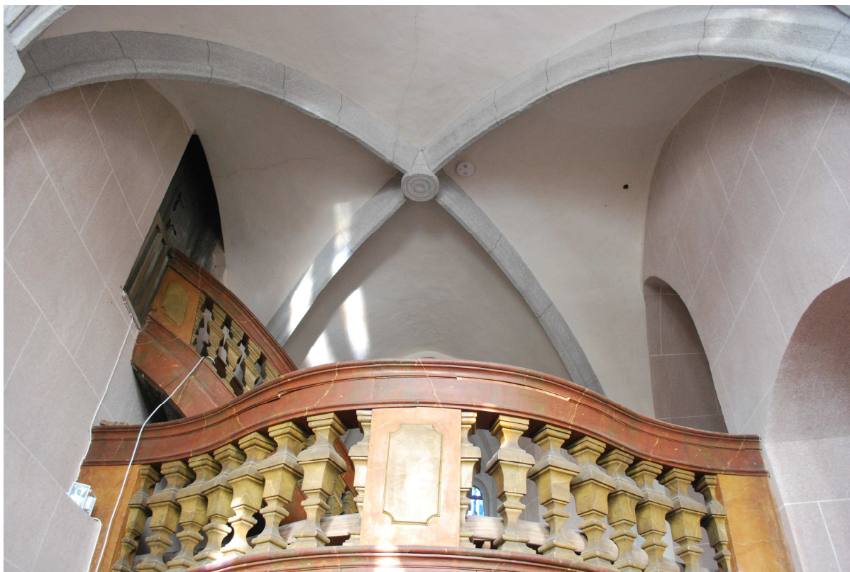
Obr. 48 – zaklenutí, dřevěná kruchta v kapli Panny Marie
