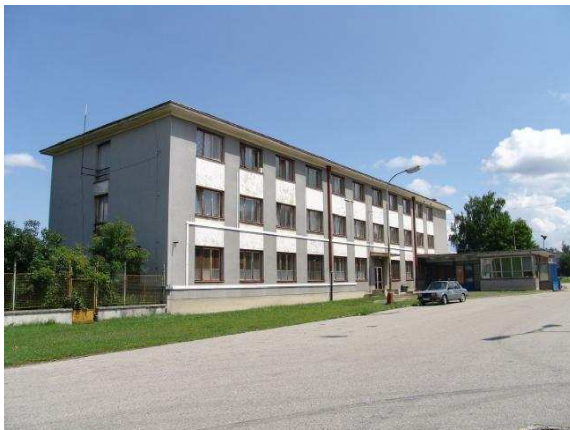
Obrázek č. 6: Elektrárna Mydlovary
