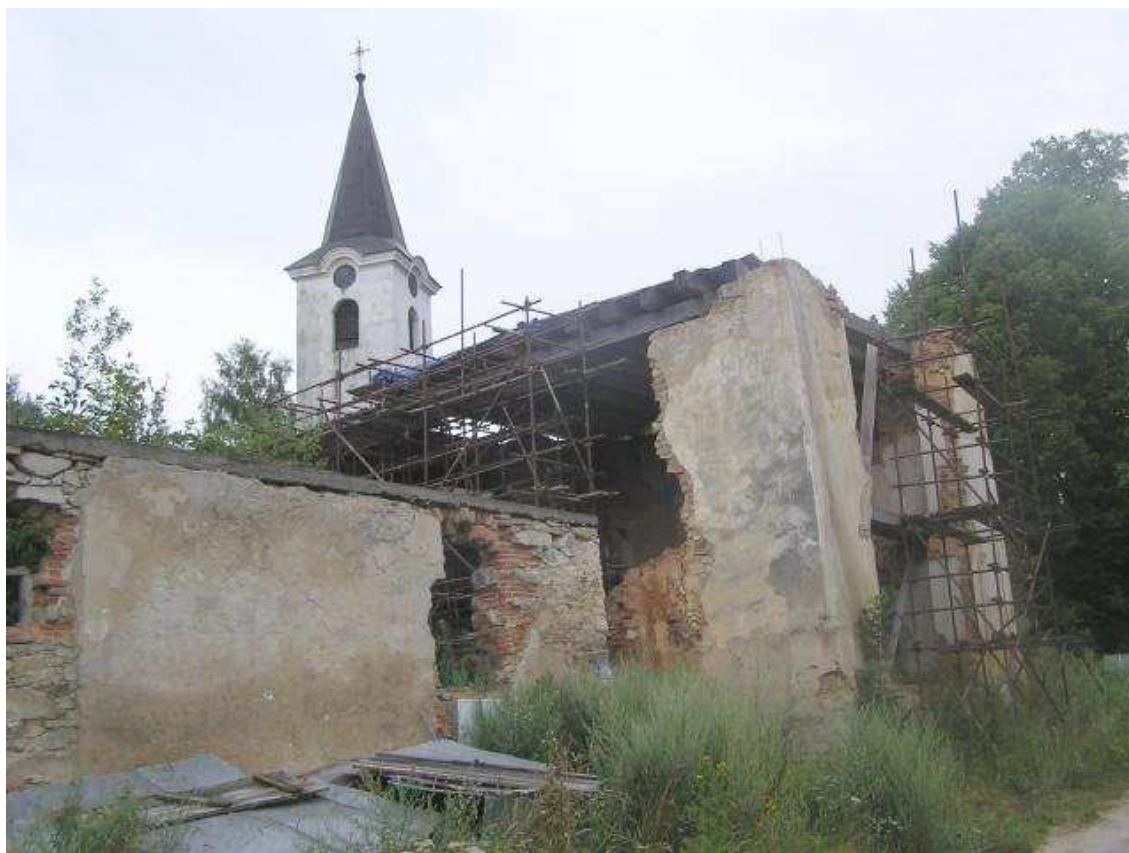
Obrázek č. 11: Kasárna Krabonoš
