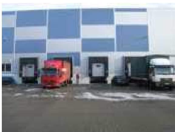
Obr. 9: Sklad Praha-Horní Počernice – 4 nájezdové rampy
