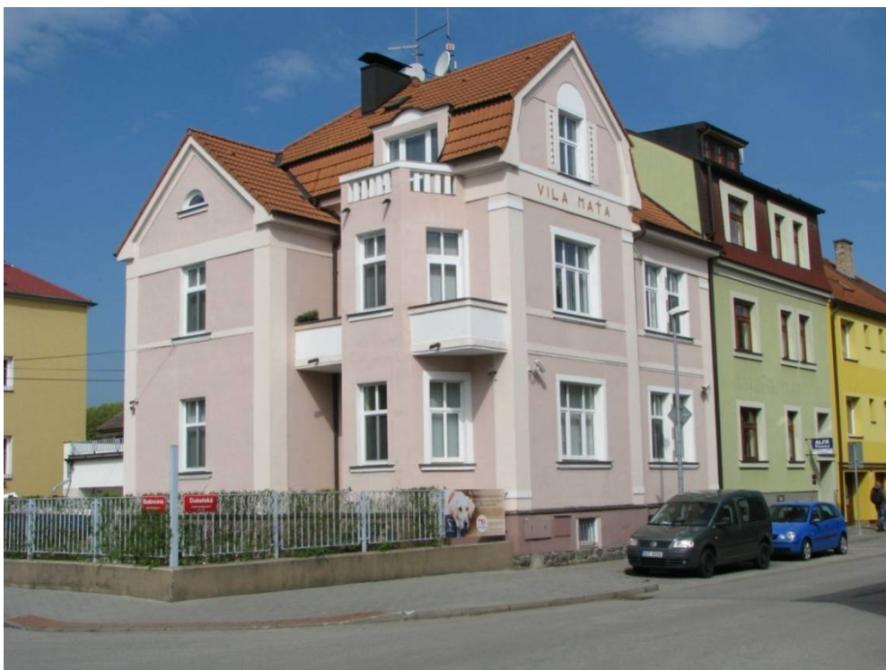
Foto 9: Rohová vila v ulici Dukelská a Budovcova (plocha č. 6)
