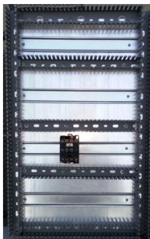
Obr. 15. - Instalace žlabů a DIN lišt (foto autor)
