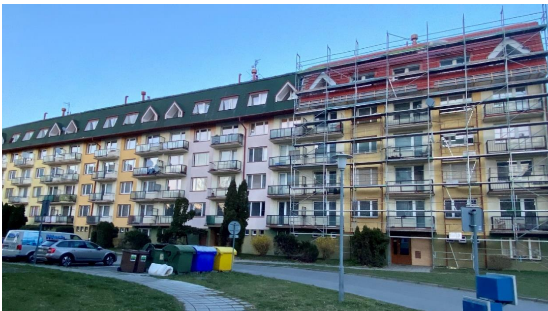
Obrázek 9.7: ulice Stavbařů – rekonstrukce (vlastní)
