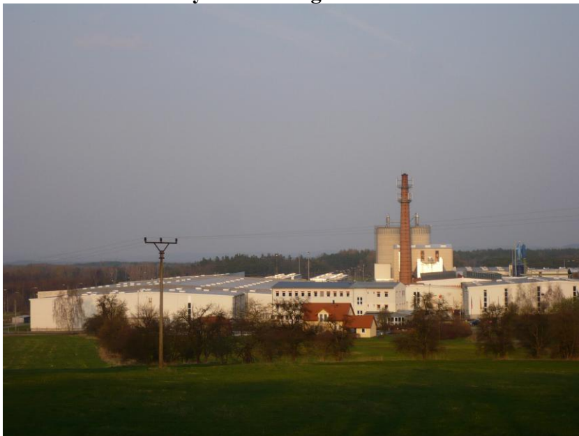
Foto 13: Areál firmy Haas Fertigbau
