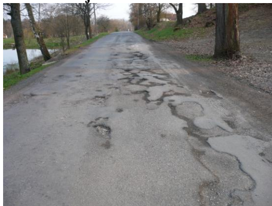
Foto 17: Příjezdová silnice z Dobrotic
