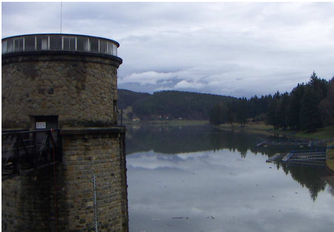
obrázek 18 : Pohled z hráze na vodní nádrž Luhačovice
