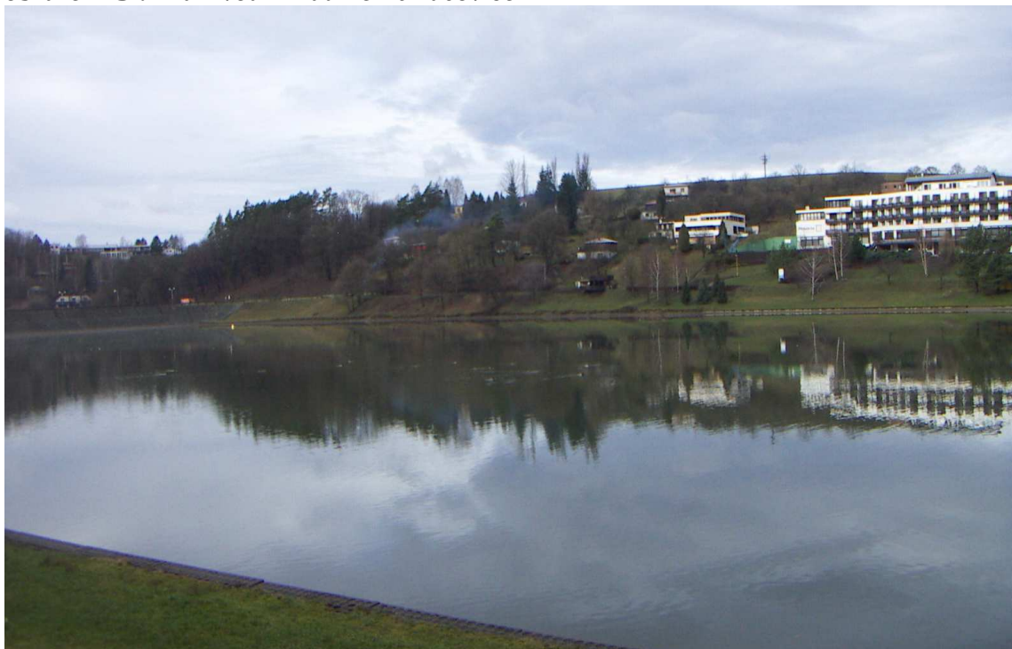
obrázek 23 : hráz vodní nádrže Luhačovice
