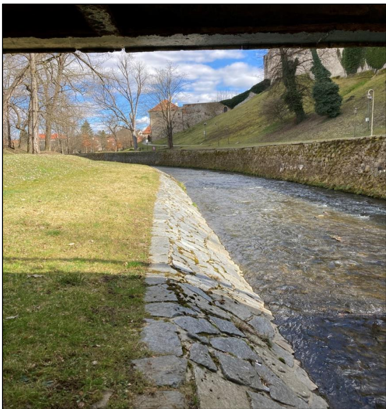
Obrázek 6: ochranné protipovodňové zdi u Jelení zahrady (Zdroj: vlastní tvorba)
