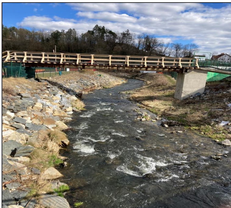
Obrázek 10: zrekonstruovaný most na fotbalové hřiště (Zdroj: vlastní tvorba)
