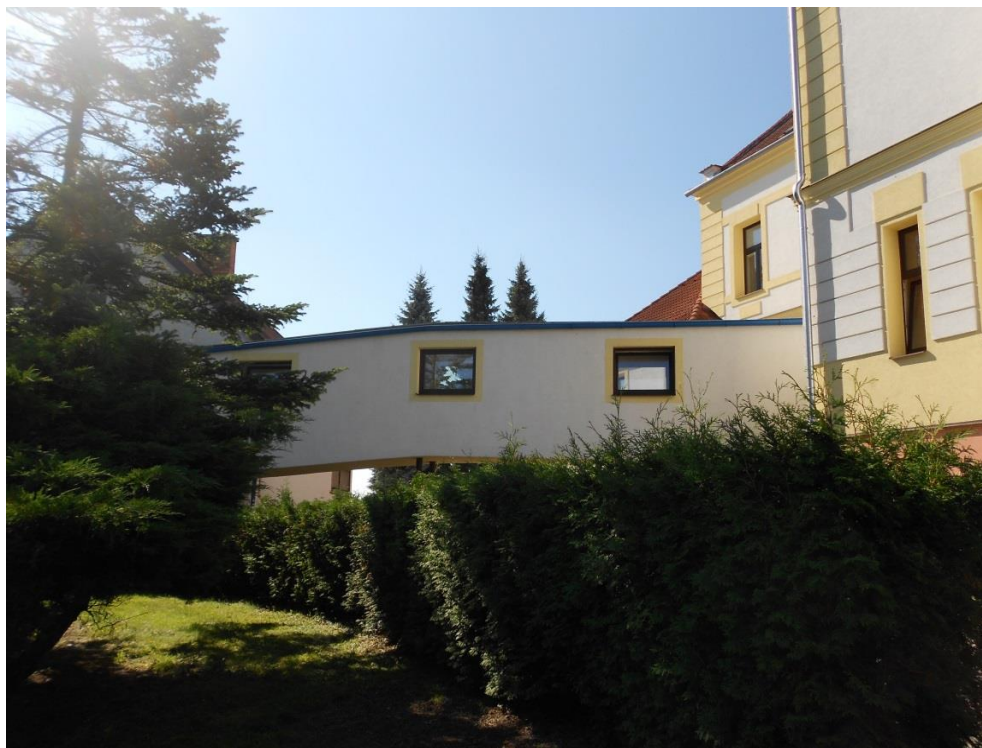
Fotografie č. 13 - Tunel spojující obě budovy stacionáře Klíček
