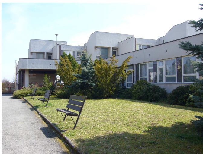
Domov pro seniory Tachov, U Penzionu 1711
